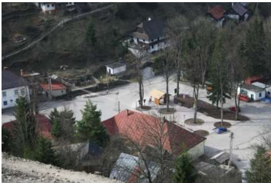
Obnovené námestie (Plac), centrum dediny, kde sa stretávajú ľudia, parkujú autá, zastavuje autobus, klebetia starenky a je tu krčma
